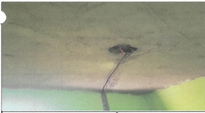
Foto 5: ENERGIA ELECTRICA DE LOS BAÑOS
