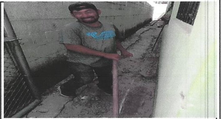
Foto 2: DEMOLICION DE DRENAJES
