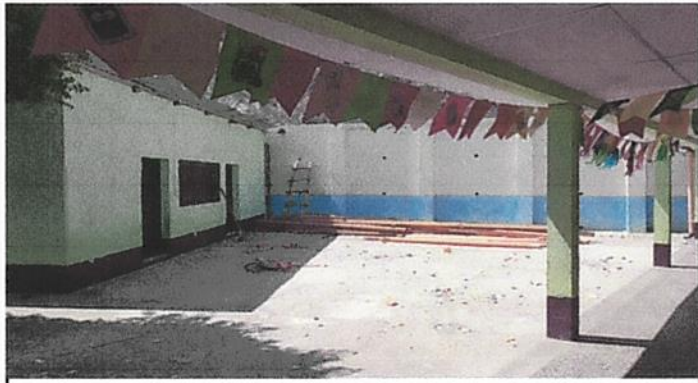
Foto 1: DEMOLICION DE GALERA
